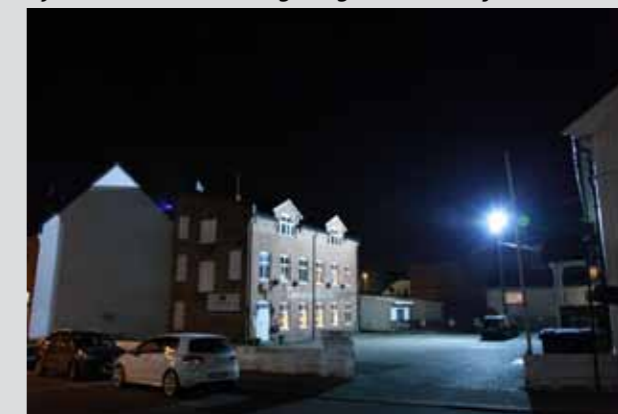
Dårligt tilpasset sikkerhedsbelysning med kraftig belysning af gårdareal med højtstående enkeltstående armatur, der giver kraftige slagskygger og stor kontrast. Synsevnen nedsættes og øvrige område vil fremstå mørke.
