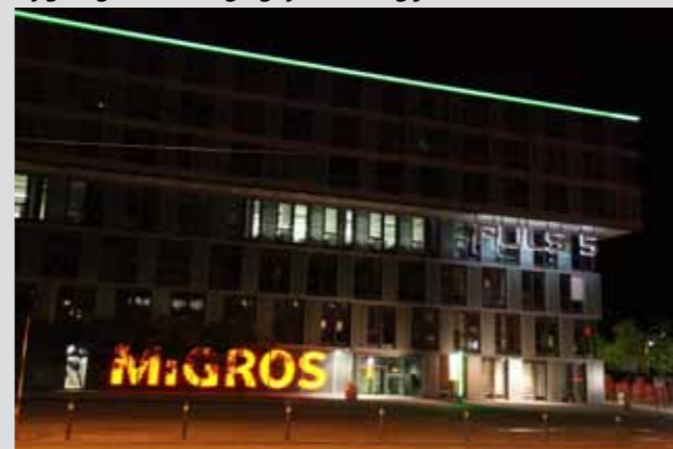
Bygningsmarkering og lysskiltning fra Zürich i Schweiz.
