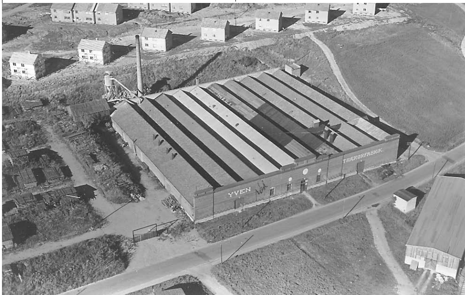
Yven trerørfabrikk 1951. Opprinnelig bygget i 1902 av Glommen Bomuldsspinderi og Væveri. I dag er det Felleskjøpet som disponerer bygningen.
