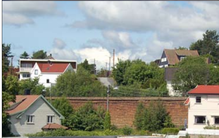
Fyllingen for Jernbanesporet utgjør en kraftig og dominerende barriere mot øvre deler av området. Samtidig representerer det et viktig kulturminne og steinhoggerhistorie i Østfold.
