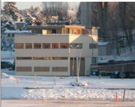
Fornyelse av Strandgata 1 med moderne leiligheter (over).
