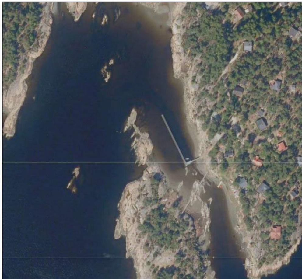
Flyfoto: Sarpsborg kommune
