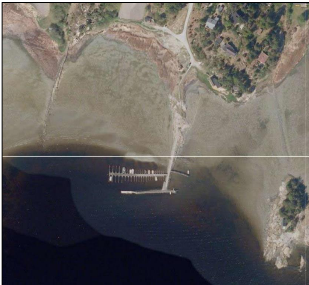
Flyfoto: Sarpsborg kommune
