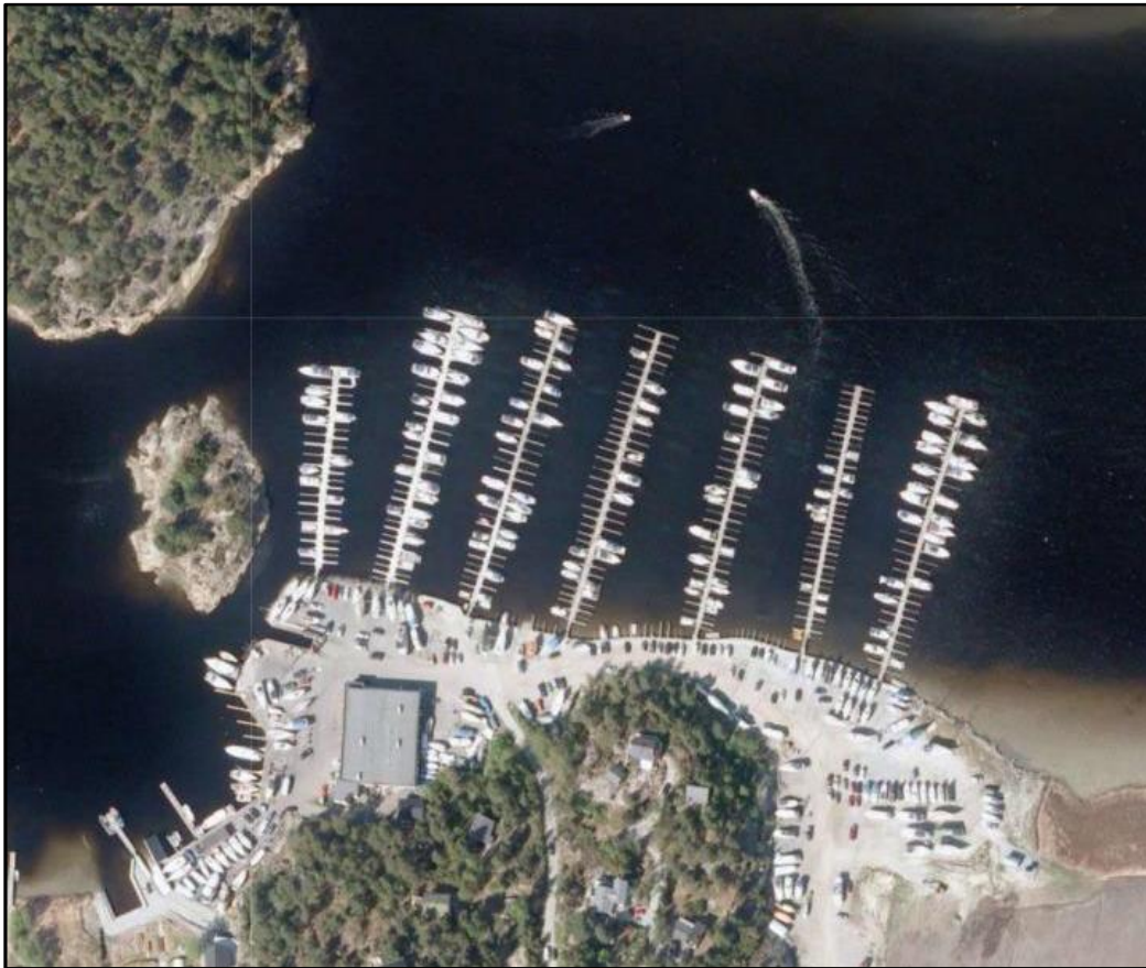
Flyfoto: Sarpsborg kommune
