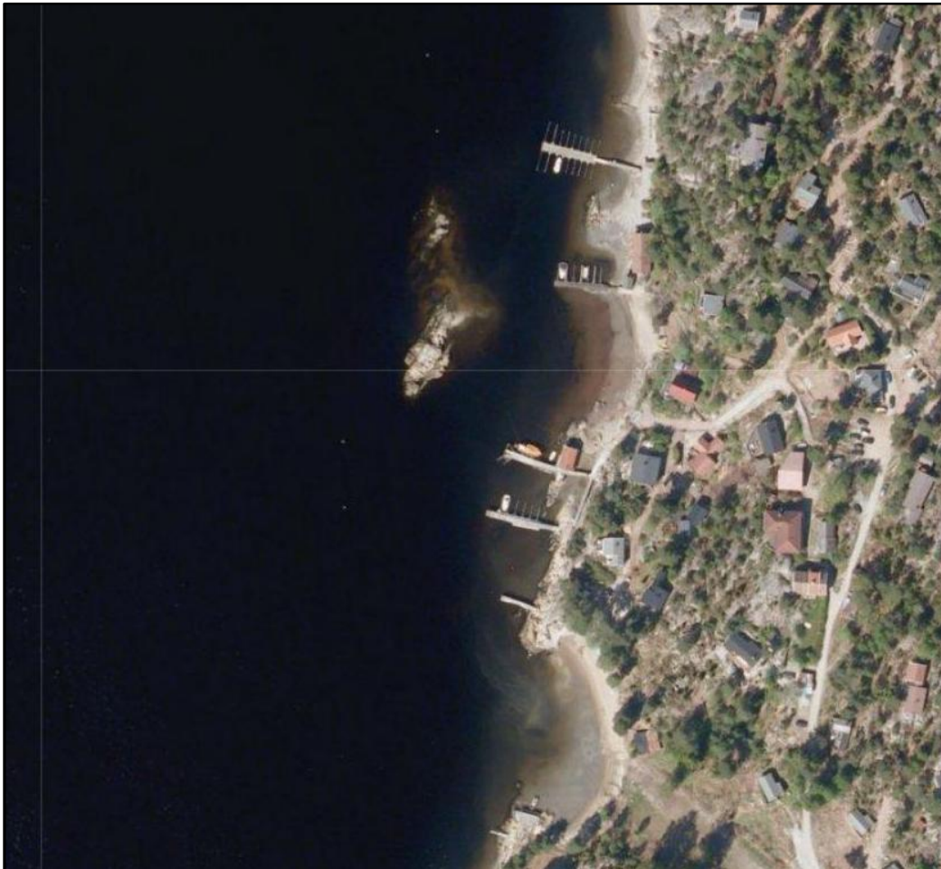
Flyfoto: Sarpsborg kommune
