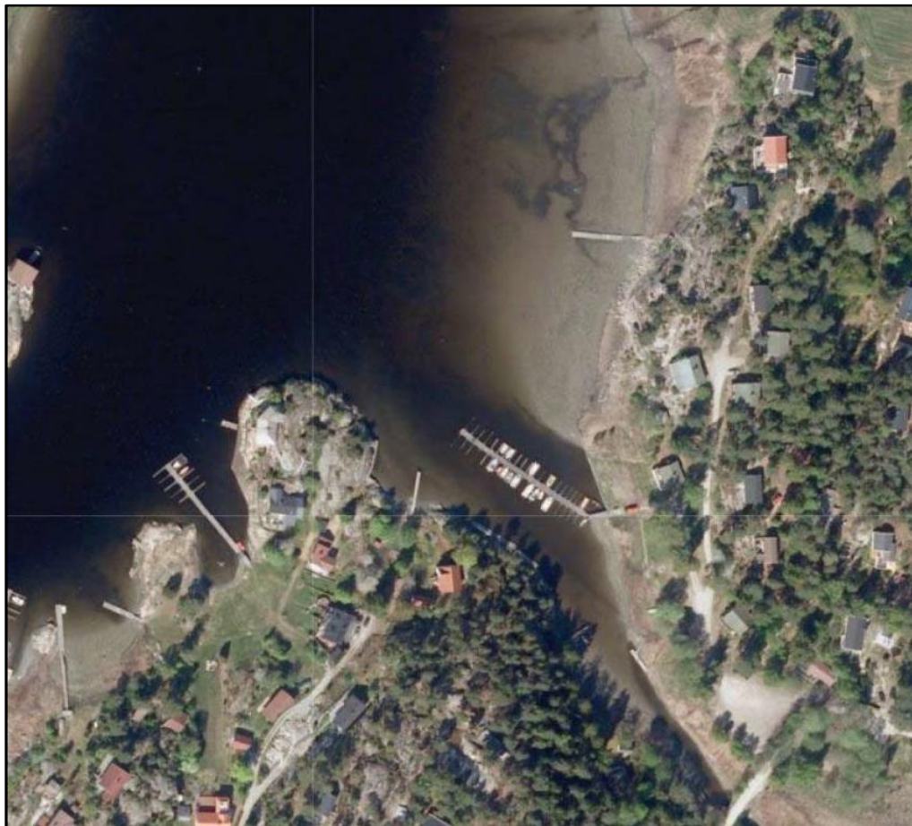
Flyfoto: Sarpsborg kommune
