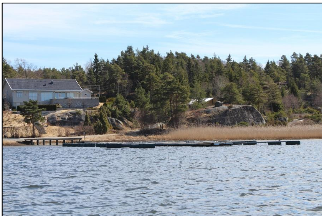
Foto av søndre brygge sett fra nordvest: Rambøll
