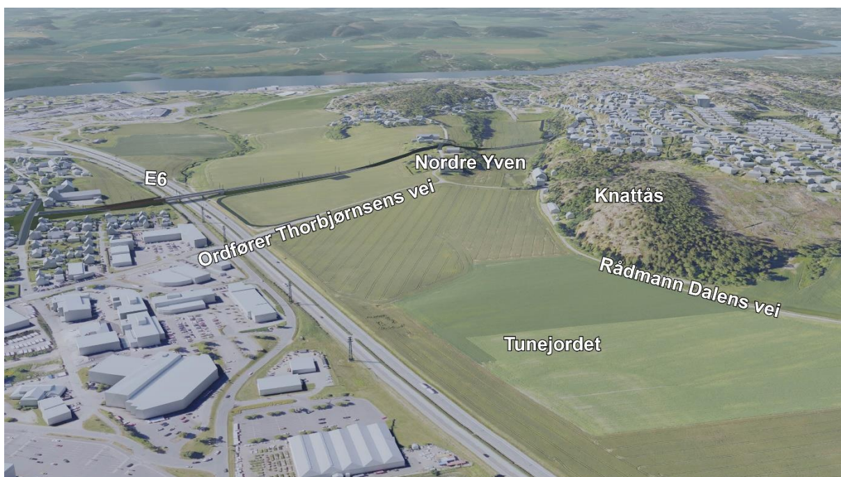
Figur 8-13: Alternativ 1a krysser nord for Nordre Yven, sett fra sør mot nord. Øst i bildet vises E6
