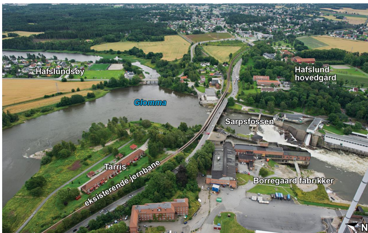
Figur 7-4: Skråfoto viser dagens situasjon ved Sarpsfossen. Tarris og Hafslund hovedgård er viktige kulturhistoriske områder (foto: Bane NOR 2015)
