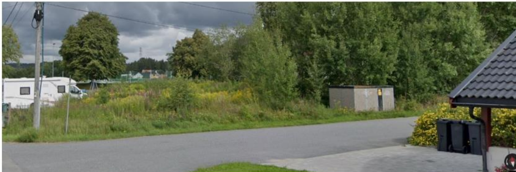
Figur 5.7 Nettstasjon langs Lillemoveien, Kilde: google maps.
