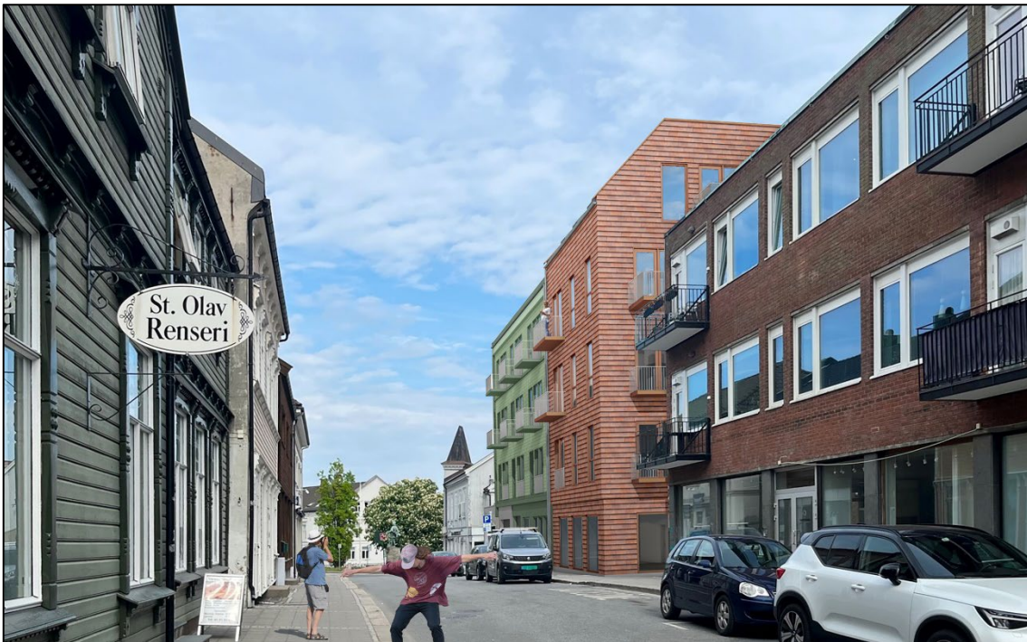
Prosjektet sett fra Torggata mot nordøst
