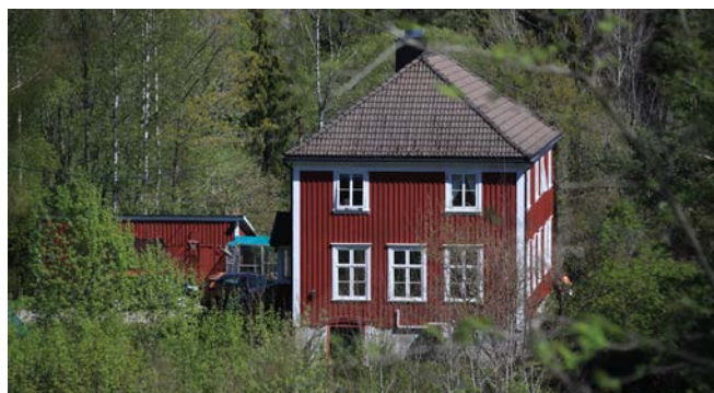
Minge skole. Oppført i 1923 og brukt som skole fram til 1950. Den gamle skolestua fra 1892 er et av klasserommene i første etasje.
