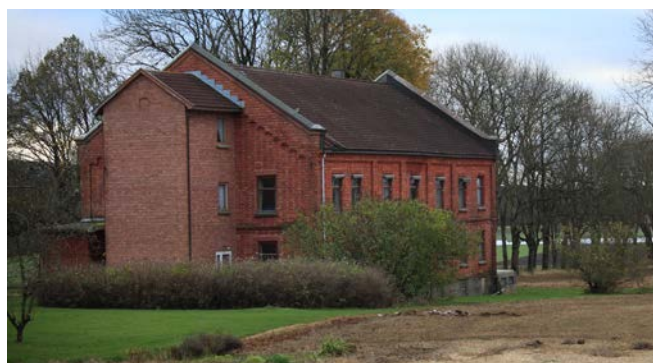
Sandbekk i Skjeberg, kjøpt som fattiggård i 1887 og ble senere omgjort til gamlehjem. Våningshus i særpreget teglarkitektur.
