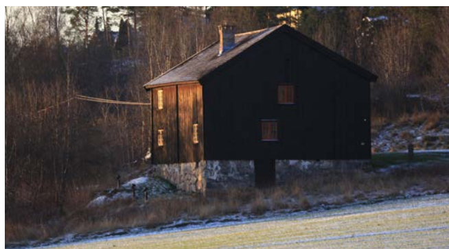
Grålumstua fra 1778 er en av få gjenværende svalgangshus i Sarpsborg. Foto: LOK.
