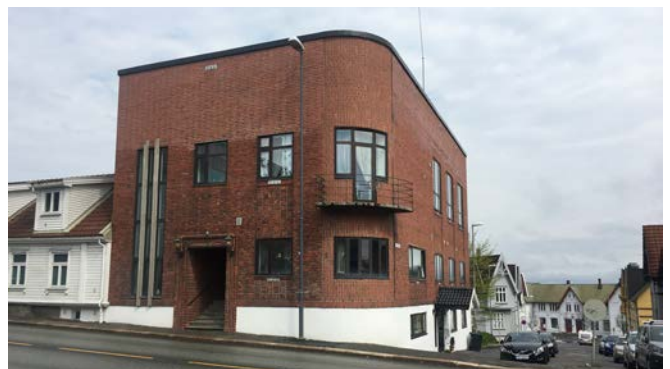
Håndverkeren i Olav Haraldssons gate 33. Art decoinspirert teglmodernisme med avrundet hjørne. Oppført 1927. Alle foto: LOK.
