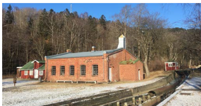
Tømmertunnelen i Eidet er et unikt teknisk-industrielt kulturminne. Det er satt opp nye skilt med god formidling om anlegget.
