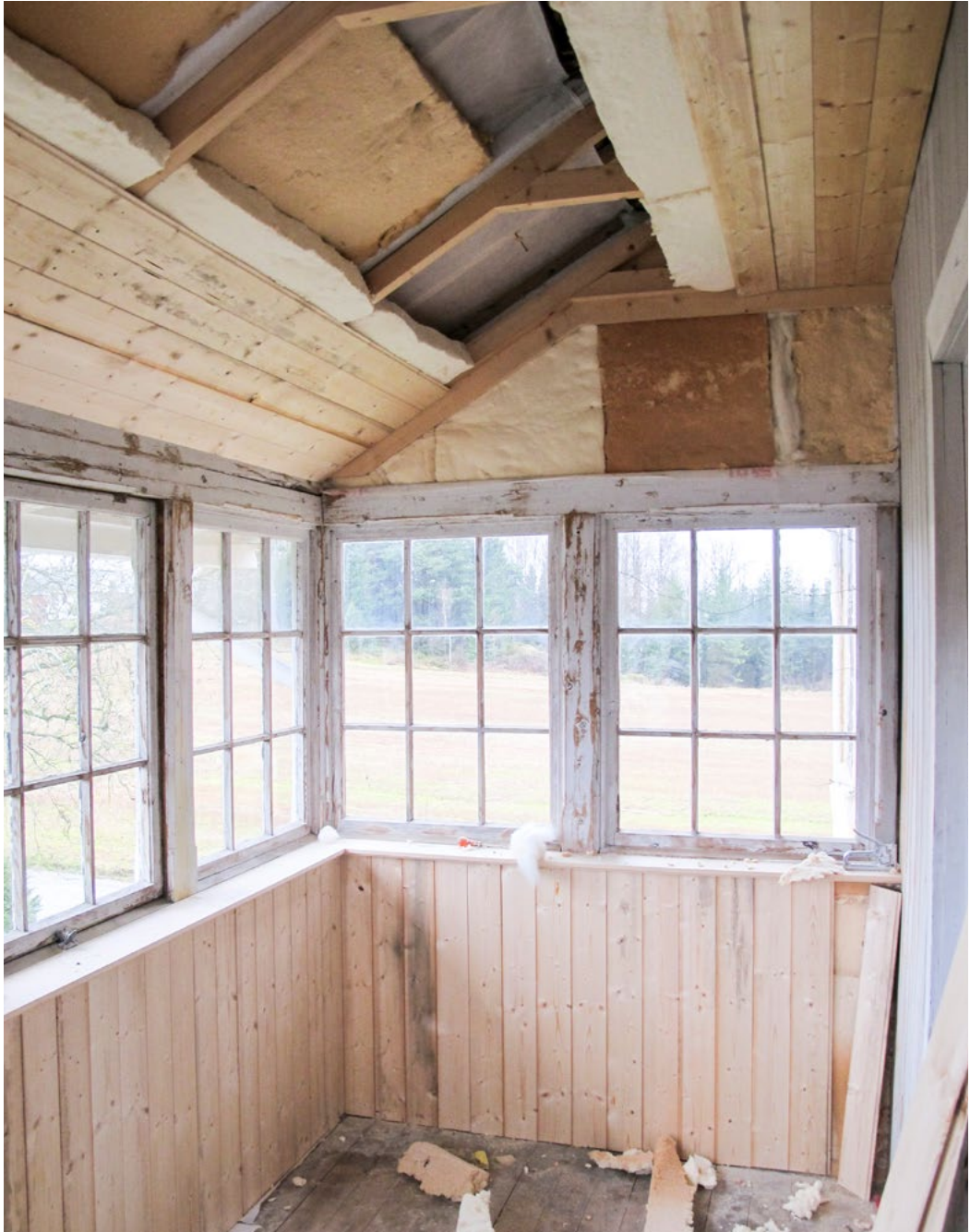
Skånsom etterisolering av glassveranda med trefiberisolasjon i plater.
