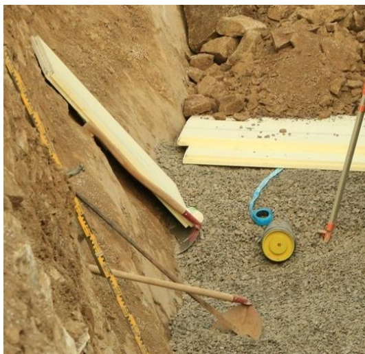
Grøft som isoleres med markisolasjon
