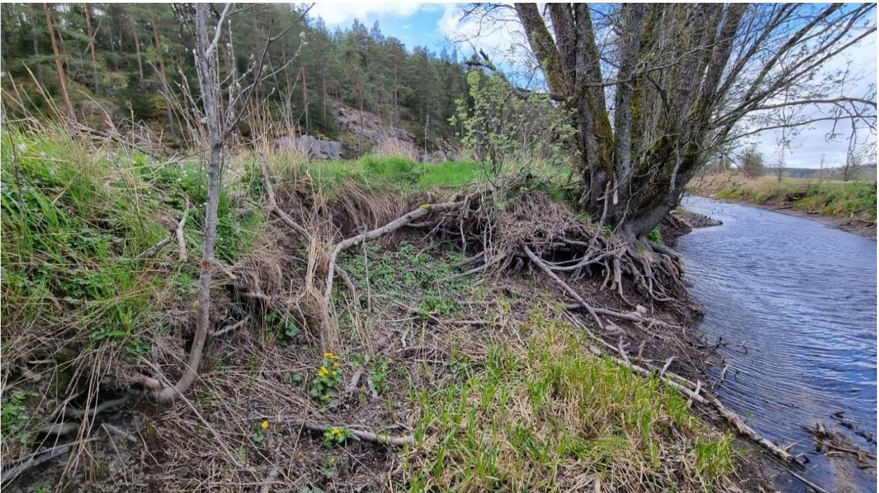
Figur 42: Erosjon i elvekant i Buerelva. Det er kort avstand til jordekant oppe til venstre. Svartor hindrer videre erosjon, men om treet velter kan det gir mer erosjon i bekkekanten. Foto: 13.05.2022
