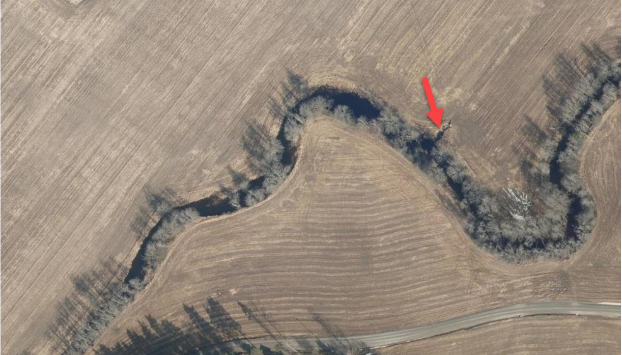
Figur 41: Eksempel på deler av rørutløp som ser ut til å være skadet (rød pil) og føre til erosjon og jordtap til Buerelva og Isesjø.
