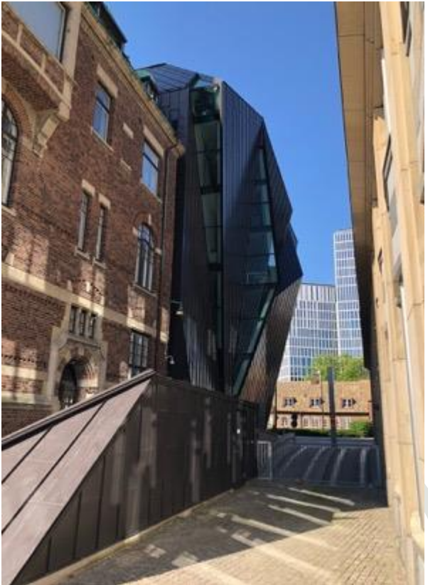
WMU Malmö med tilbygg i front, Malmö LIVE hotell/kongress/konsert i bakkant
