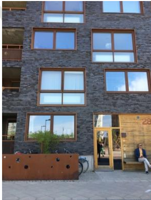
Forarealer med sittebenk og sykkelparkering. Boliger i Västra hamnen, Malmö
