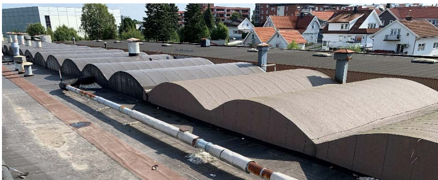
Figur 11 Taket på Buehallen, med bølgetak. (Foto: Dronninga landskap)
