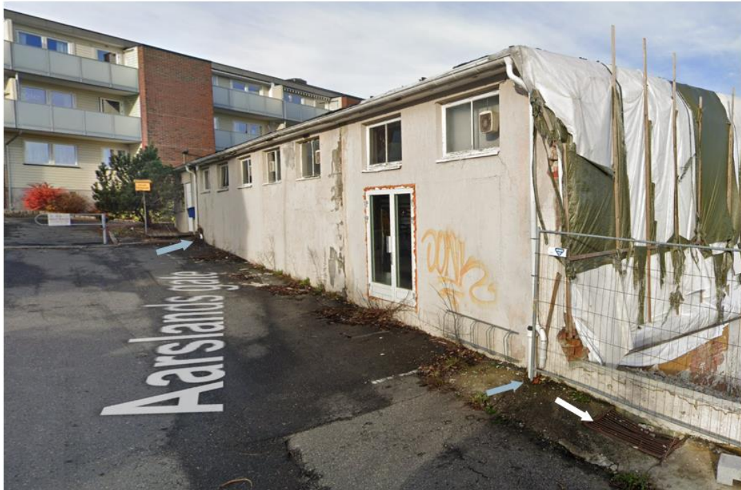
Figur 7 Markering av taknedløp med blågrå piler, sluk er markert med hvit pil. Kilde: Google maps
