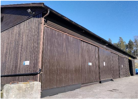
Stående tømmermannspanel, miljøstasjon.
