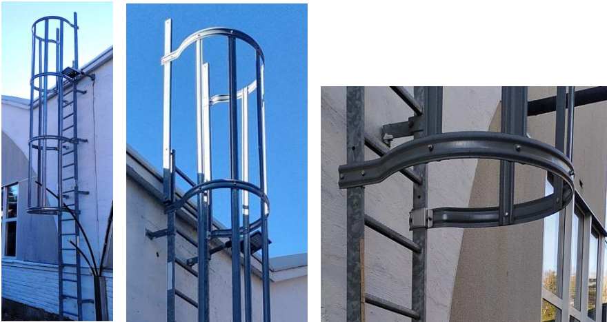
5 stk utvendige rømningsstiger langs fasade mot øst. Høyde på stigen fra fot til topp rekkverk= 6,40 m. Rekkverket rager 125 cm over takkant. 1 av 5 stiger er noe kortere.
