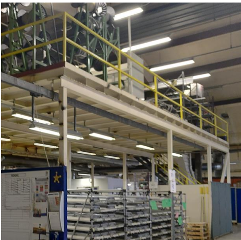
Stålprofiler i messanin, 2 etg produksjonshall (218).
