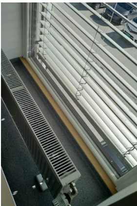
6 stk vinduer i 3 etg administrasjonsfløy (319) fra 2010. Mål på isolerglass=1380x2058 mm. 6 stk vinduer med tilsvarende kvalitet, men lavere høyde i 2 etg.
