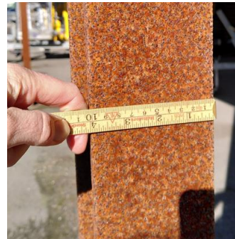
Stålprofiler som bæring av utvendig tak langs vestfasade produksjonshall. Angrepet av rust
