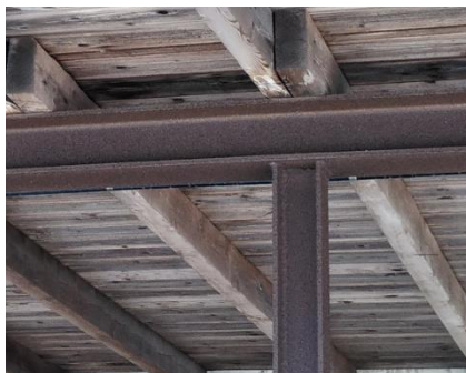
Stålprofiler som bæring av utvendig tak langs vestfasade produksjonshall. Angrepet av rust
