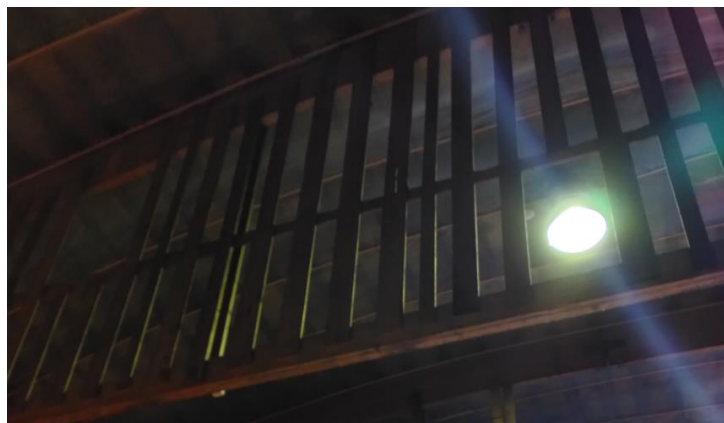
Buede tredragere i hall, vestfløy (198) - 11 stk med og uten vertikale avstivere. Lengde kan sjekkes på målriktige tegninger.
