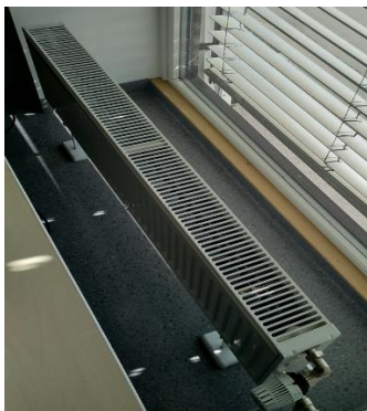
Radiatorer av nyere dato, observert i 2 + 3 etg adm fløy, der opprinnelig spisesal er bygget om til kontorer
