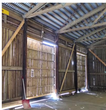
Konstruksjonstrevirke i miljøstasjonen nord i anlegget. Her virket takstoler, liggende spikerslag, taklekter og utvendig kledning å være i trykkimpregneret materiale, mens stolpene er antatt kreosotimpregneret.
