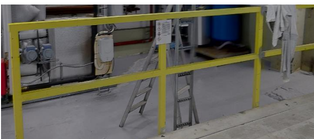
Rekkverk i firkantstål (40x40 mm) på mesanin produksjonshall 2 etg, og i fyrrom (186)
