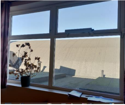
Trevindu i 3 etg administrasjonsfløy (319) fra 2006. Mål= ca 300x200 cm. 4 glassfelt, hvorav de 2 øverste er topphengslede åpningsvinduer.
