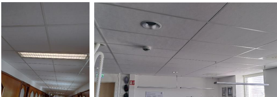
Mineralullhimling i T-profil:
