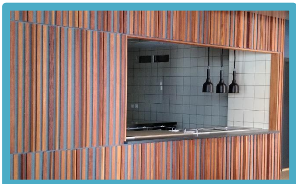
Ombruk av teak-spiler i innvendig kledning, Skur 38 9
