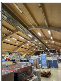
Takarmaturer med LED i produksjonshall, 2 etg, (foto og tekst fra TDD-rapport)
