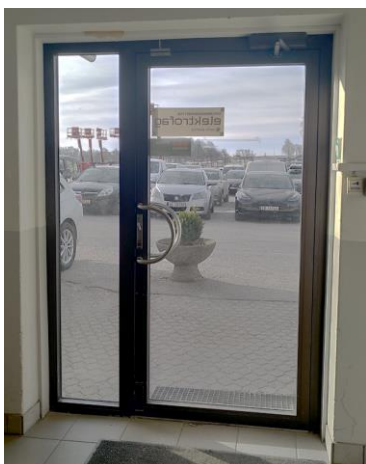
2 stk ytterdører i stål/ glass med sidefelt, ved hovedinngang administrasjonsbygg (133+135). Dørene er fra 2015. M= 160x210 (1 stk v + 1 stk h)
