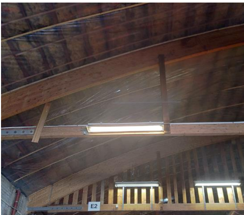
Buede tredragere i hall, vestfløy (198) - 11 stk med og uten vertikale avstivere. Lengde kan sjekkes på målriktige tegninger.
