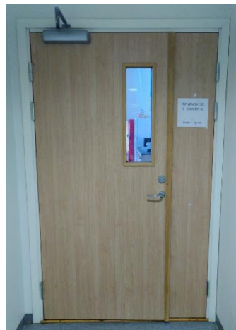
Branndør til hc-toalett 247 (M=100x210 cm), og mellom spisesal og korridor mot øst 292 (M=130x210)
