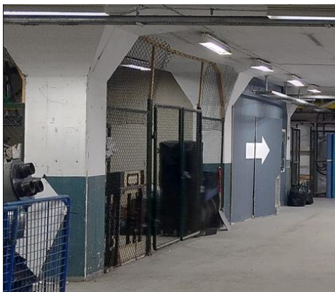
Betongsøyler i 1 etg/ underetasje
