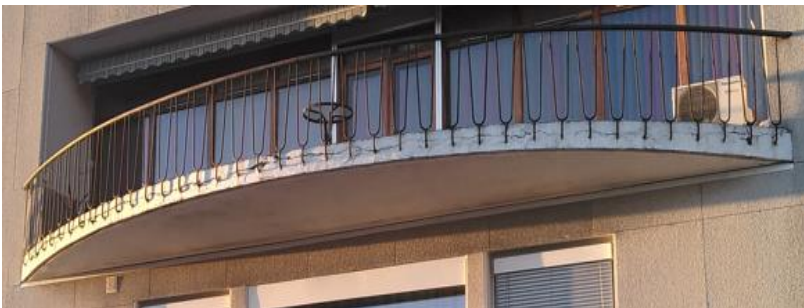
Originalt rekkverk i stål på balkong, 3 etg adm fløy
