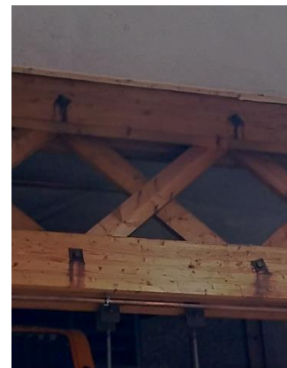
Buede tredragere i hall, vestfløy (198) - 11 stk med og uten vertikale avstivere. Lengde kan sjekkes på målriktige tegninger.
