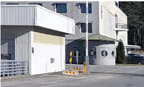
6 runde vinduer i vaktpost-rom, diameter=85 cm
