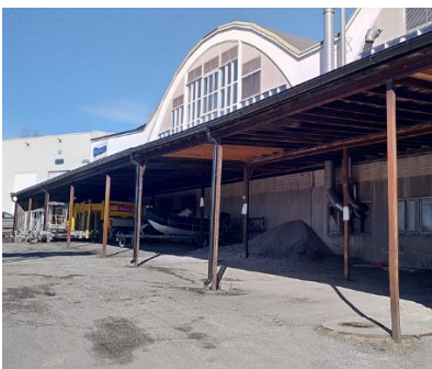
Stålprofiler som bæring av utvendig tak langs vestfasade produksjonshall. Angrepet av rust
