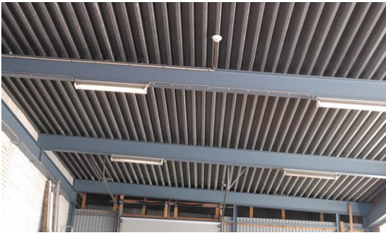
Stålsøyler og dragerer med TRP-tak i mottakshall, vestfløy (170)
