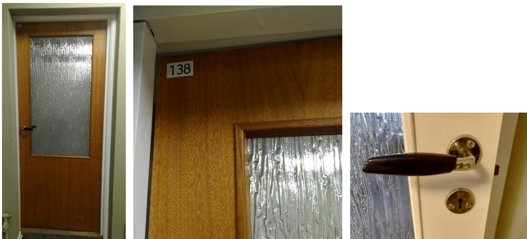
12 stk finerte kontordører med translucent glass i rom 138, eldre type. M=ca 78x210. Noen dører er overmalt. Dørtypen finnes også i andre deler av administrasjonbygget, f.eks rom 103.
