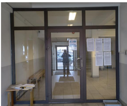
Veggfelt med dør i stål/ glass, ved hovedinngang administrasjonsbygg (135)
