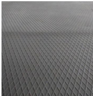
Stålplategulv i mesanin, 2 etg produksjonshall (218). Platene er ca 7 mm tykke, og måler 1x2 m.
