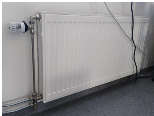
Radiatorer av nyere dato, observert i 2 + 3 etg adm fløy, der opprinnelig spisesal er bygget om til kontorer
