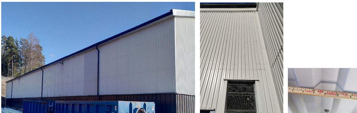
Platene har bredde 200 cm, høyde antatt 340 cm. Profilsnitt horisontalt c/c 10 cm, profildybde 1,7 cm.
