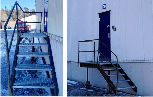
Utendørs ståltrapp på nordsiden av anlegget. 5 opptrinn. H= 105 cm, bredde 90 cm
