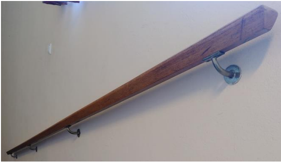
Originalt rekkverk i stål med håndløpere i tre, hovedtrapp adm fløy
