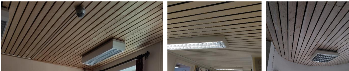
Himling i tre i 2 etg adm.bygg mot øst (rom 204-211) og i 1 etg adm.bygg mot vest (rom 108-110)
