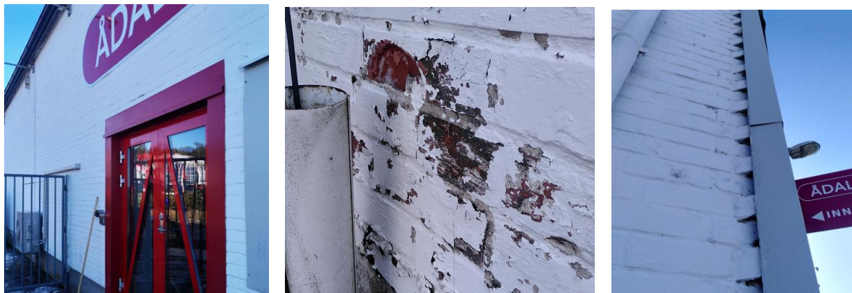
Tegl i yttervegg, vestfløy - inkl detalj mot hjørne Trøskenveien. Tegl er her eksponert i fasade mot nord, mens de andre fasadene er kledt med korrugerte stålplater
