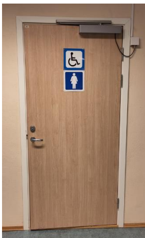
Branndør til hc-toalett 247 (M=100x210 cm), og mellom spisesal og korridor mot øst 292 (M=130x210)
