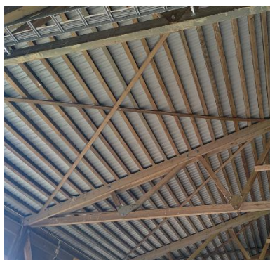
Konstruksjonstrevirke i miljøstasjonen nord i anlegget. Her virket takstoler, liggende spikerslag, taklekter og utvendig kledning å være i trykkimpregneret materiale, mens stolpene er antatt kreosotimpregneret.
