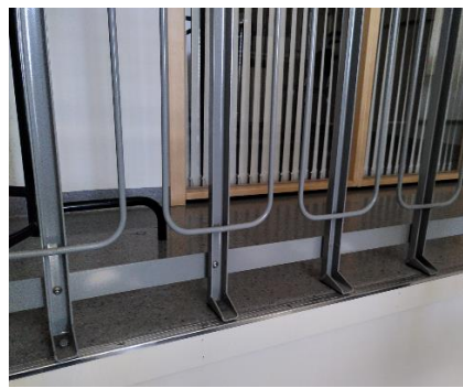
Originalt rekkverk i stål med håndløpere i tre, hovedtrapp adm fløy
