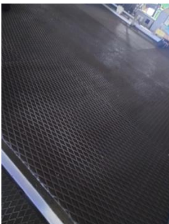
Stålplategulv i mesanin, 2 etg produksjonshall (218). Platene er ca 7 mm tykke, og måler 1x2 m.
