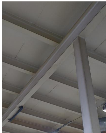
Stålsøyler og dragerer med TRP-tak i mottakshall, vestfløy (170)
