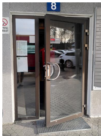
2 stk ytterdører i stål/ glass med sidefelt, ved hovedinngang administrasjonsbygg (133+135). Dørene er fra 2015. M= 160x210 (1 stk v + 1 stk h)
