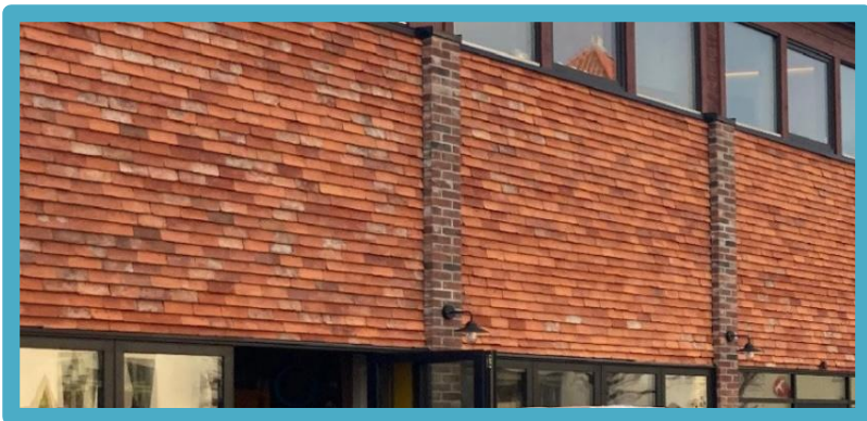
Ombruk av heltegl i søyler og oppsirkulering til skjermtegl i fasadekledning 8
