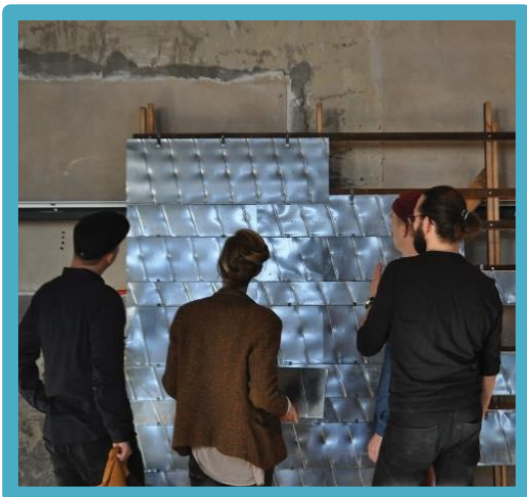
Oppsirkulering av ventilasjonskanaler til kledning 11
