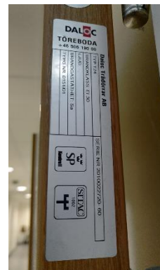
Branndør til hc-toalett 247 (M=100x210 cm), og mellom spisesal og korridor mot øst 292 (M=130x210)
