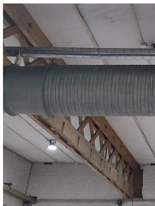
Trefagverk i hall 195+197. 14 stk. Lengde kan sjekkes på målriktige tegninger.
