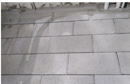
Betongmurstein i delevegg mellom lagerhall 149 og 181
