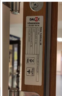
Branndør til hc-toalett 247 (M=100x210 cm), og mellom spisesal og korridor mot øst 292 (M=130x210)
