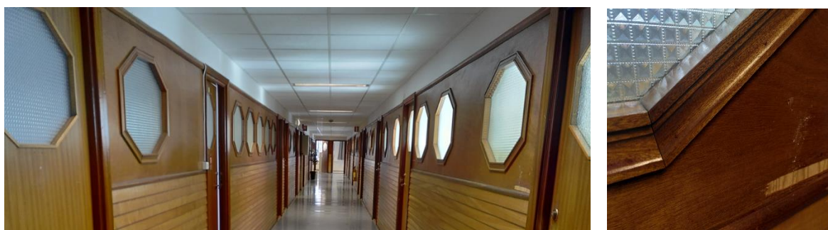
Korridorvegg med teak-vinduer, 3 etg. administrasjonsfløy. Dører og øvre veggfelt i mahognyfiner
