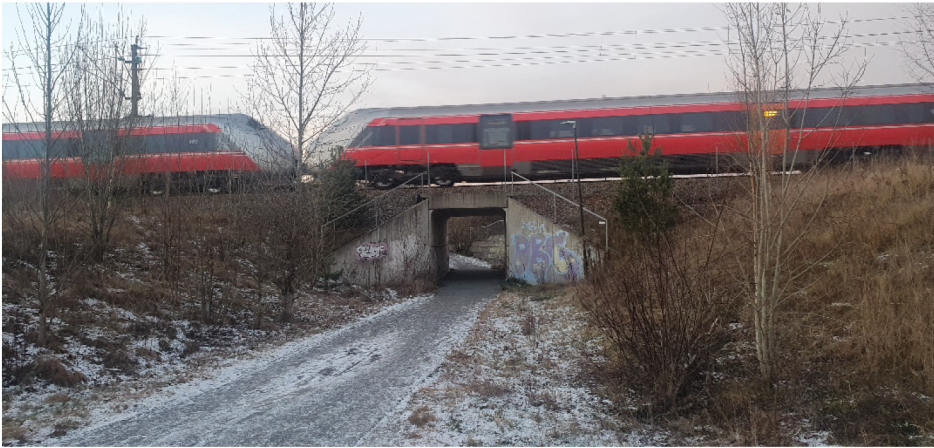
Fig 15 - Undergangen sett fra syd.
