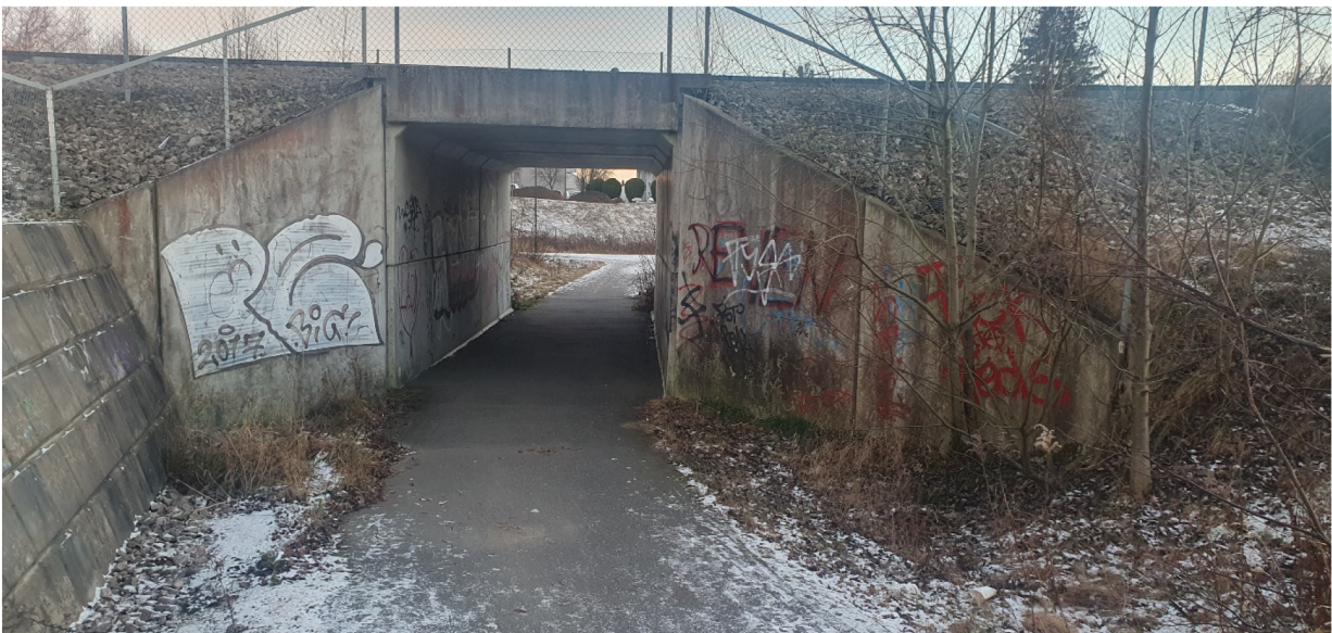
Fig 14 – Undergangen måler ca 2x2,5 m og er produsert av Brd Østbye, Elverum.
