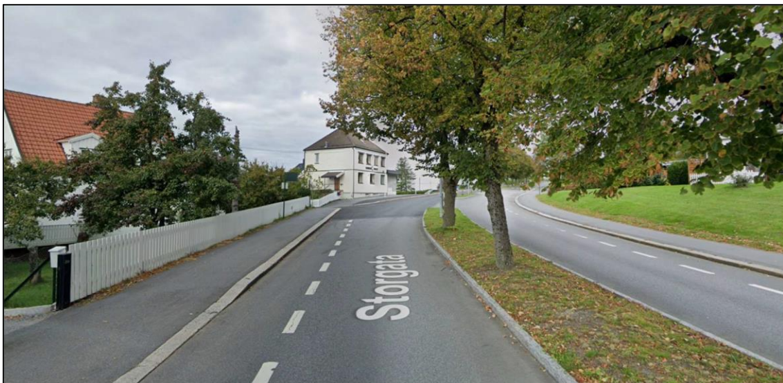
Figur 10: Sangerhuset sett fra Storgata, mot nord.
