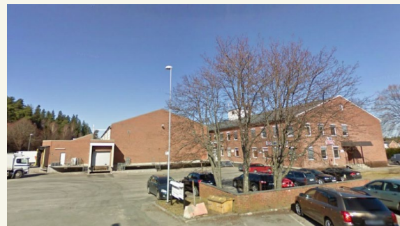
Bilde: Østfoldmeieriet fasade mot Tors gate (Hentet fra Google Maps Streetview, 2010).
