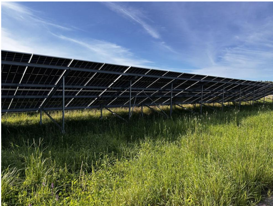
Figur 11 - Montasjesystem for solcellepaneler
