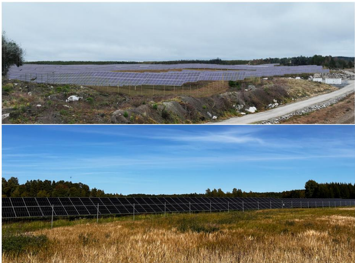
Figur 13 - Inngjerding av solkraftverk
