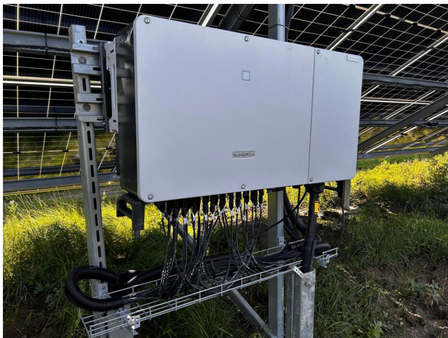
Figur 8 – Vekselretter montert på festestruktur
