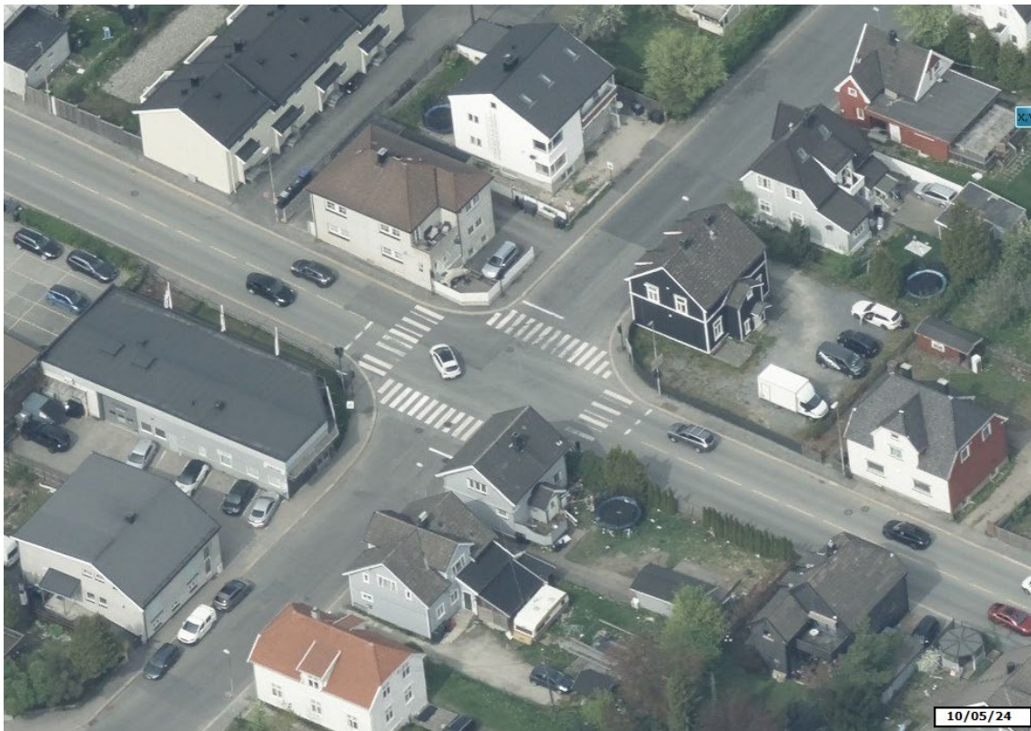
Figur 12: Oversiktsbilde fv. 118 x Rosenkrantz gate (10.05.2024)
